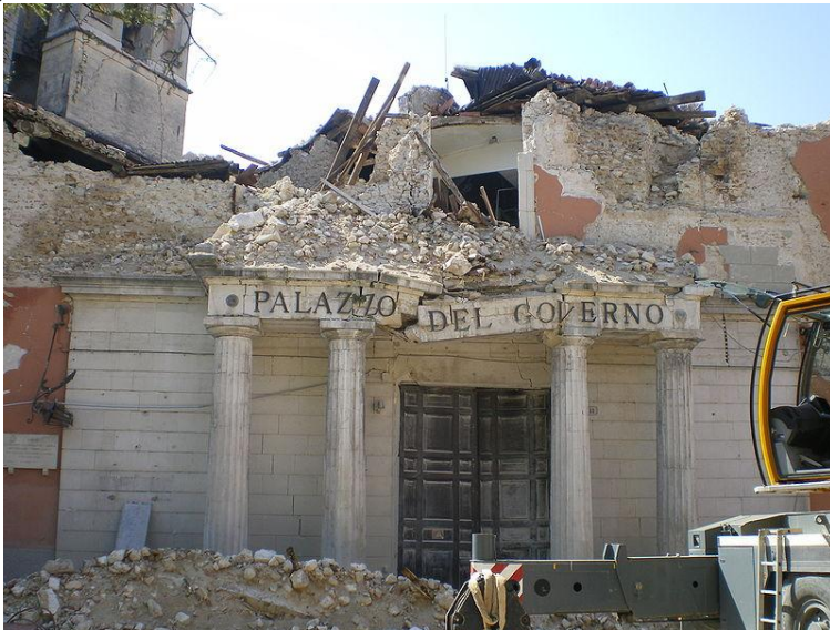
La prefettura dell'Aquila dopo il terremoto del 6 aprile 2009
