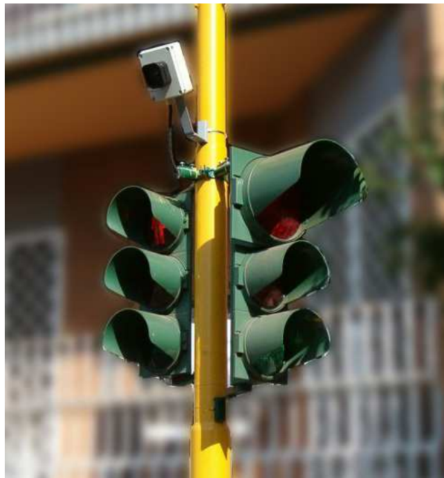
Impianto semaforico con avviso sonoro
